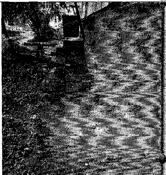
Фото 5,6. Отмостка. Наличие трещин и отхождение отмостки от стен здания. Следы замачивания стен. Наличие растительного слоя на отмостке. Локальное разрушение штукатурного и окрасочного слоя.
